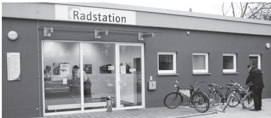
Eingangsbereich und die daneben liegenden Funktionsräume, der Putz ist »SkF-Rot«.
